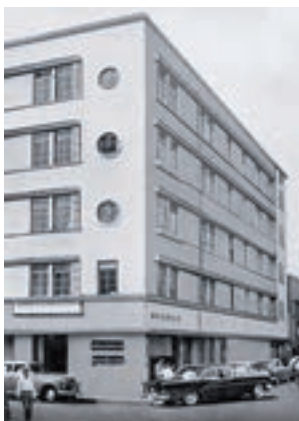
日本所建物(昭和24年当時)
